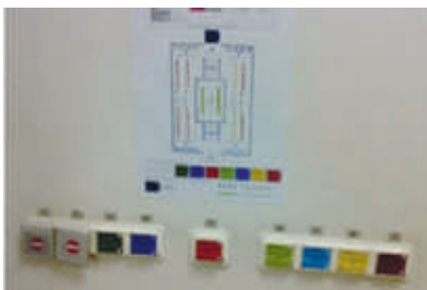
Инструкция на стене
